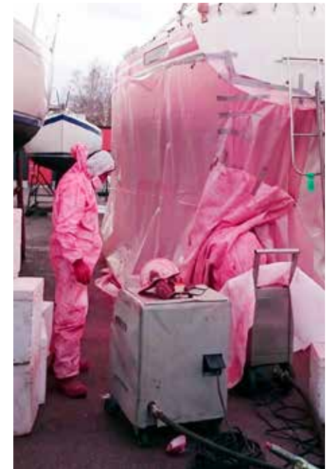
Bilden visar hur en felaktig blästring kan ge upphov till mycket damm som sprids till omgivningen.
